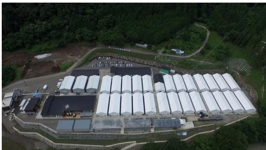
図 2-03 電気と廃熱を供給する上野村きのごセンター
